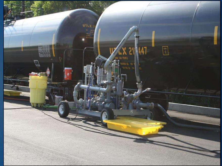
Instalación de transbordo
